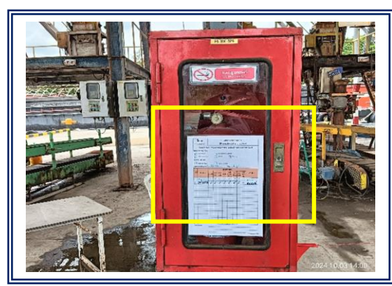
รูปที่ 3-57 ป้ายแสดงการตรวจเช็คถังดับเพลิง
