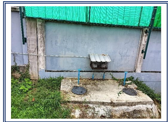
รูปที่ 3-15 ถังบำบัดน้ำเสียสำเร็จรูปชนิดเติมอากาศแบบ Aerobic Fixed Film
