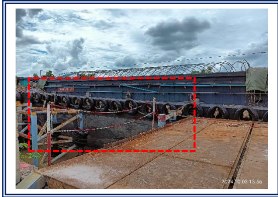
รูปที่ 3-58 ราวกันตกที่ด้านข้างของท่าเทียบเรือ และ Safety Platform
