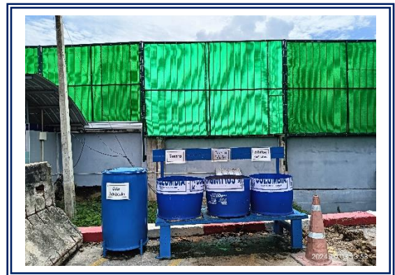
รูปที่ 3-44 ถังเก็บทรายดูดซับ
