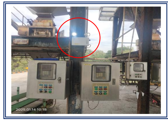
รูปที่ 3-54 ระบบไฟฉุกเฉินแบบหลอด LED บริเวณท่า เทียบเรือ
