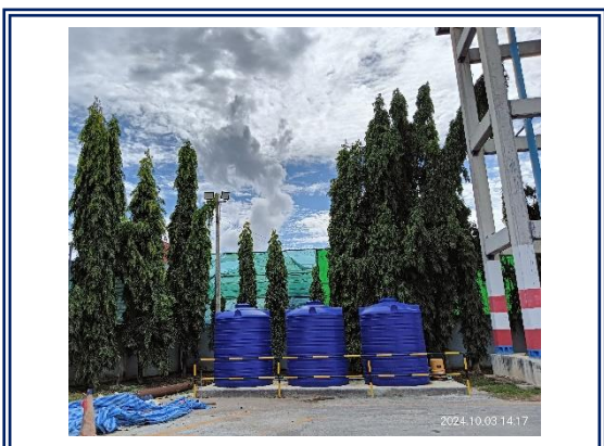
รูปที่ 3-40 ถังสำรองน้ำใช้ปริมาณอย่างน้อย 15 ลูกบาศก์เมตร
